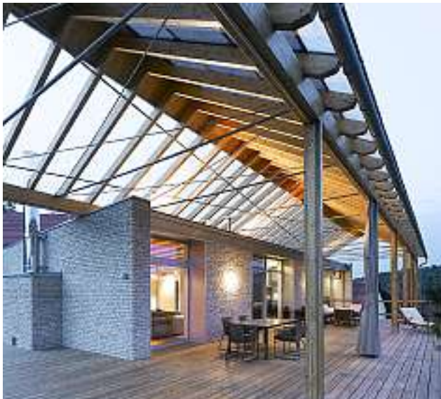
Die Photovoltaikzellen im Glasdach liefern Strom und sorgen für Beschattung
